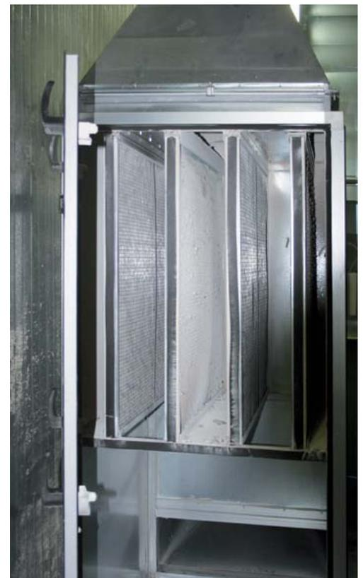
**13 e 14 - L'impianto di aspirazione e un suo dettaglio: l'unità filtrante posta ad altezza uomo consente un accesso rapido per gli interventi di manutenzione e pulizia.**
